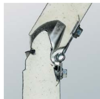
Dichtung zwischen den einzelnen Paneelen
