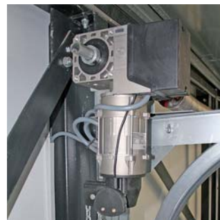
GfA-Antrieb mit Notentriegelung und Abrollsicherung
